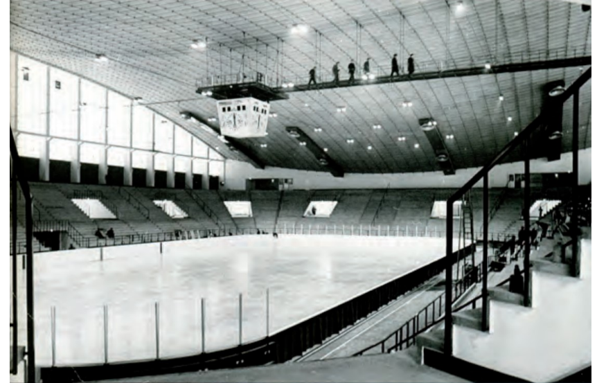
Hallin päätila lopputarkastuksen aikaan vuonna 1965. Tarkastajat kulkevat kellokallilla 18 metrin korkeudessa. Kuva: Hirvikallio, 2015; Leinonen, 2015
