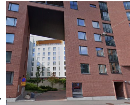
Kulkuaukko piha-alueelle. (Kalasatama, Helsinki)
